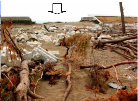
図 36 防潮堤の破堤部分と背後のマツ林内に打ち上げられた大型の破片（久慈市野田海岸）
