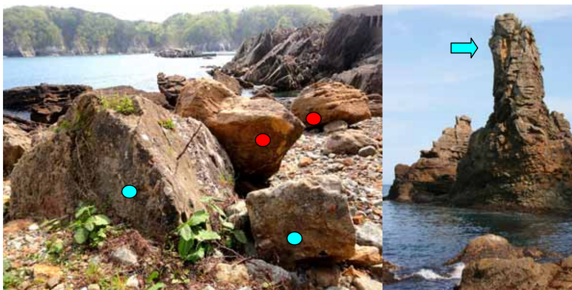
図 29 過去に崩落したと思われる既存の岩（● 植生と地衣類の生育あり）と今回の崩壊と移動で供給された岩（● 明るい黄褐色の岩）、写真右の岩では一部が欠損、崩落している。しかし、その堆積位置は不明。
