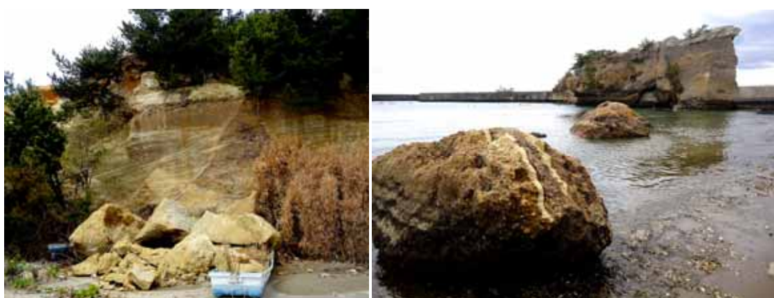
図 3 3.11 東日本大震災の地震・津波時の斜面崩落と海域に横たわる津波石と思われる巨石 (宮城県七ヶ浜町)(2011年5月撮影)
