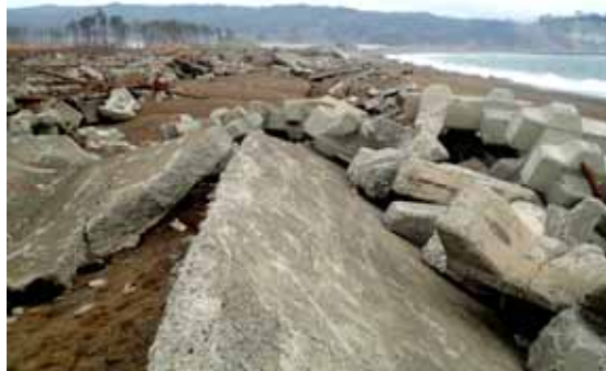
図 32 防潮堤の破壊で散乱する破片や消波ブロック（久慈市野田海岸）
