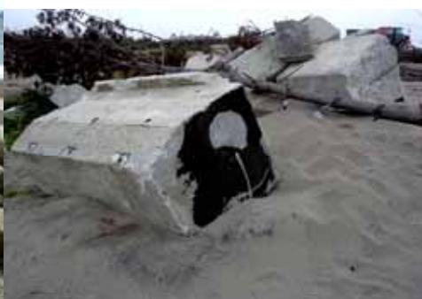
図 33 砂浜海岸林内に打ち上げられた防潮堤の破片（宮城県仙台市海岸）
