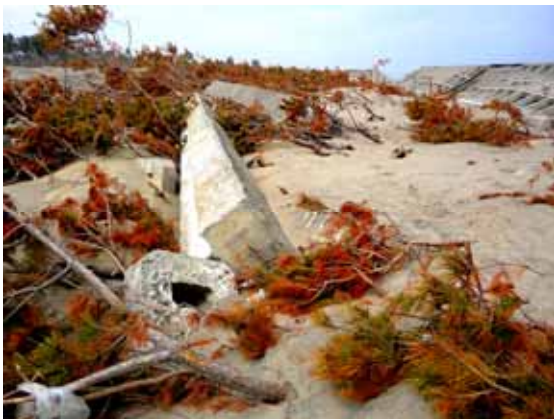
図 36 防潮堤の破堤部分と背後のマツ林内に打ち上げられた大型の破片（久慈市野田海岸）
