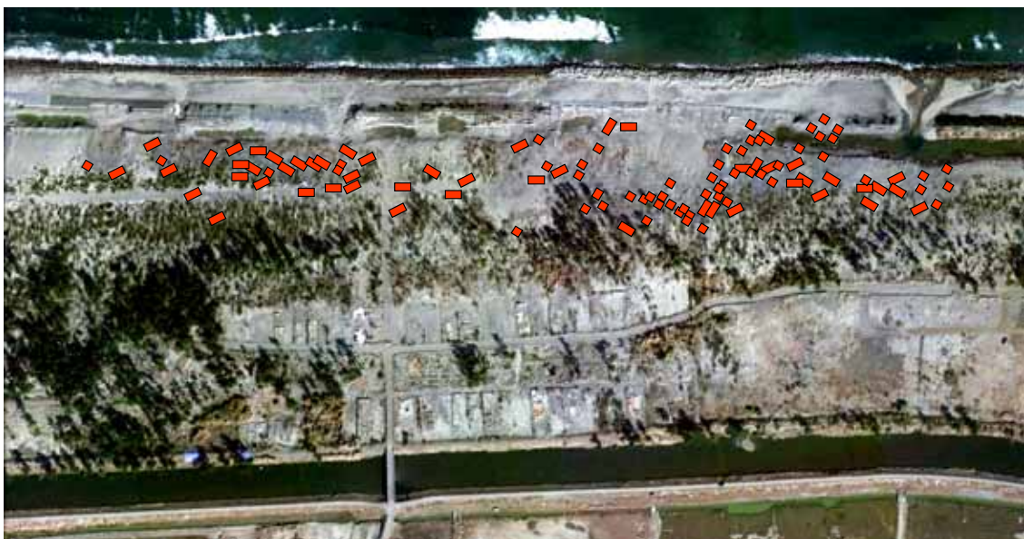
図 37 防潮堤の破壊で移動した破片、移動距離は最大約 120m(宮城県岩沼市寺島海岸)
