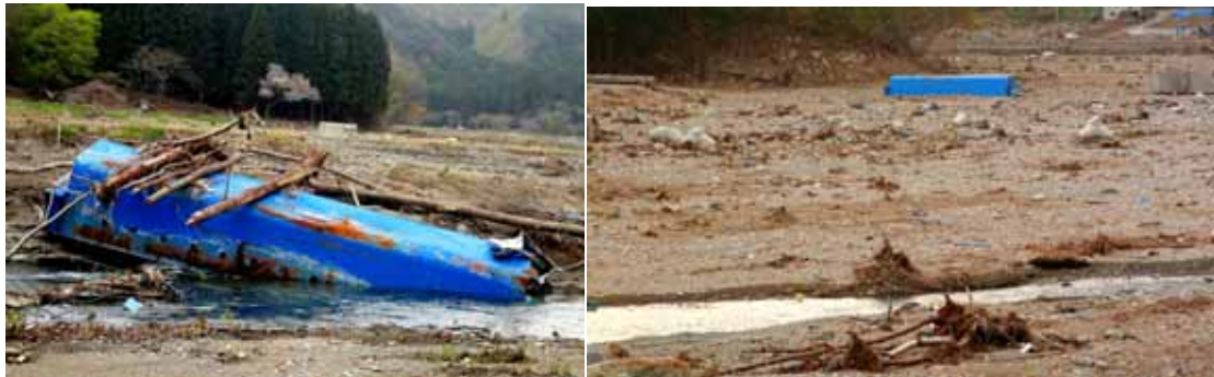
図9 鉄製の防潮水門は破壊され、直線距離で約600m流されている(2011年5月撮影)
