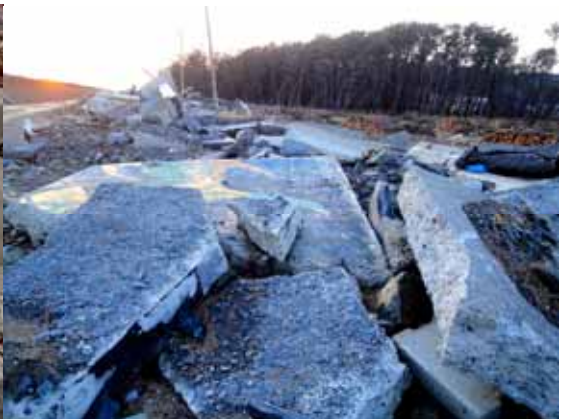
図 35 石巻市渡波地区の防潮堤の破片
