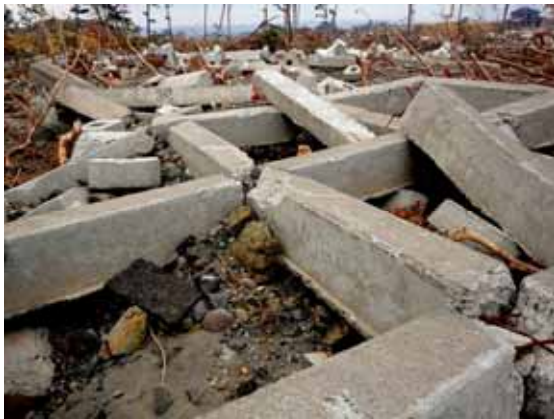
図 34 久慈市野田海岸の防潮堤の破片
